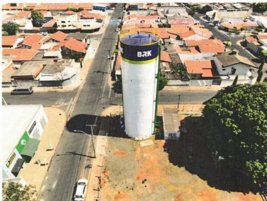
Figura 12 - Novo reservatório instalado no CR João Paulo.
