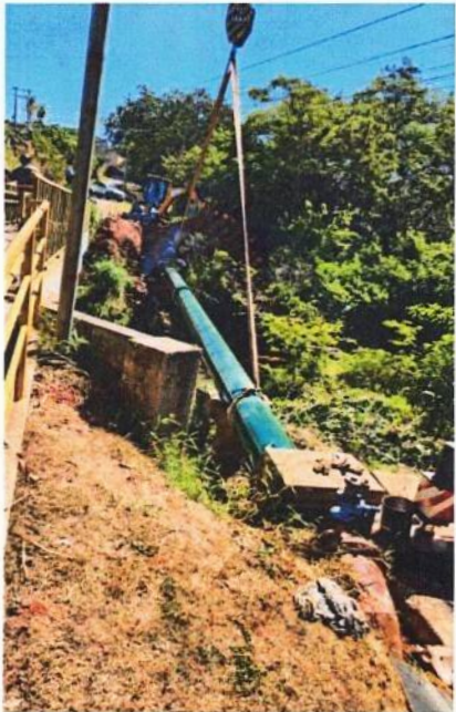
Figura 8 - Travessia adutora Matão.
