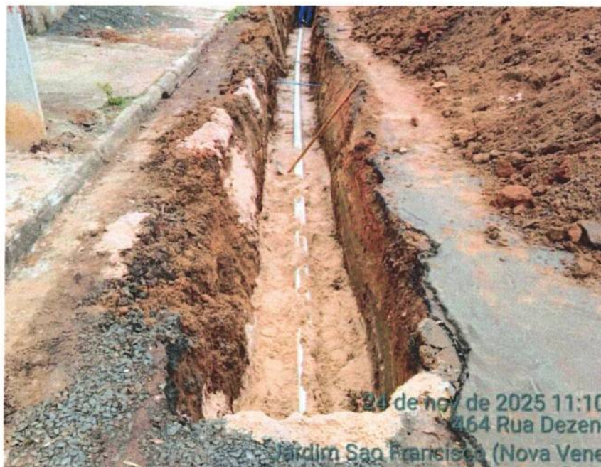
Figura 15 - Implantação da Tubulação de 100mm em PVC-O.
